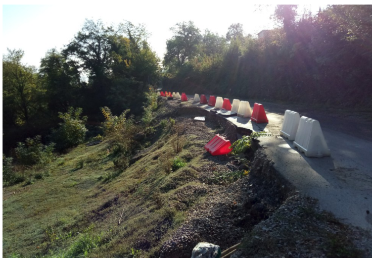
Il fronte di frana aperto (foto ottobre 2017)
